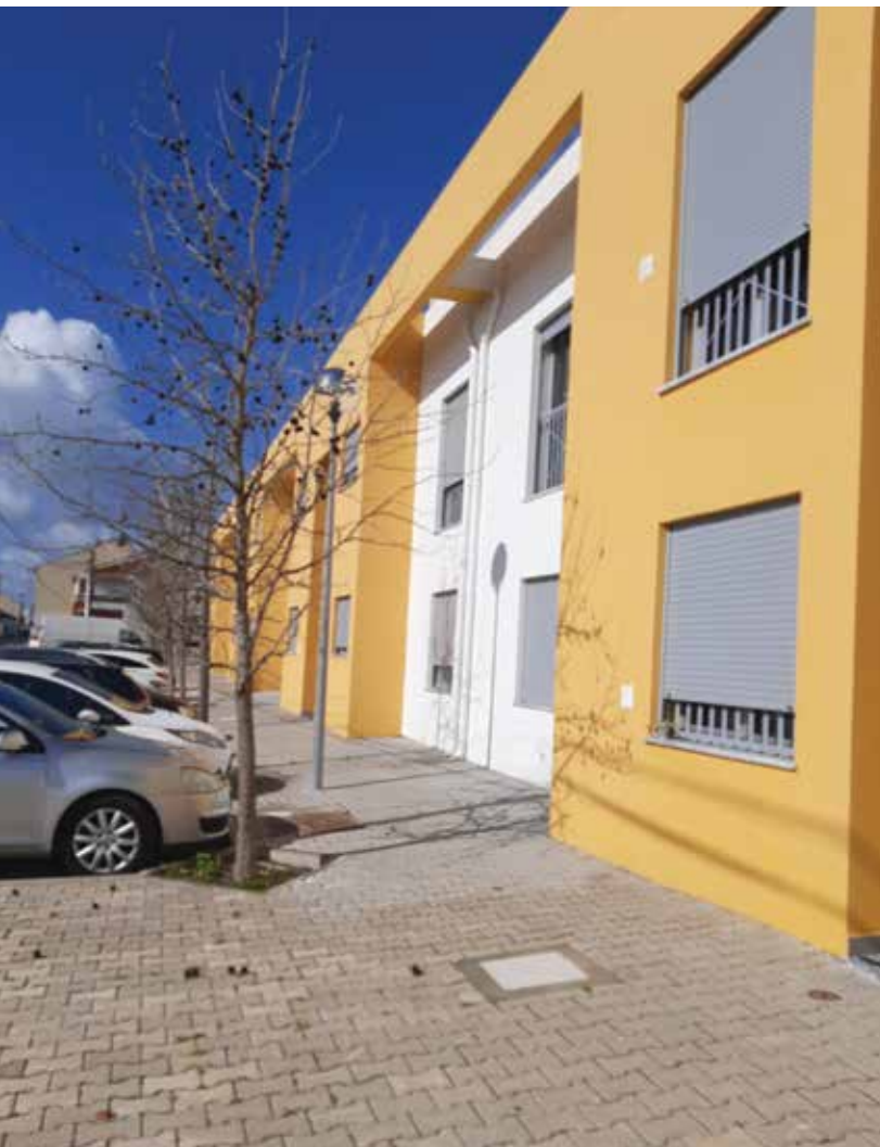
16 fogos para habitação na Rua José Carlos Ary dos Santos, em Grândola Construção concluída em março de 2023, pela Cooperativa Habigrândola
